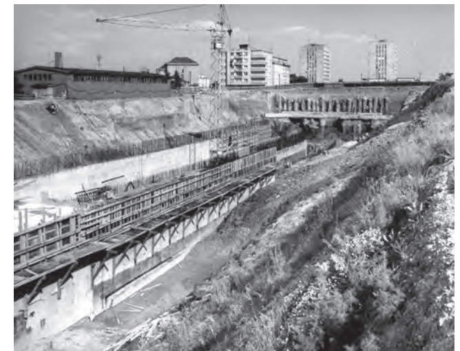
Figure 10 Construction of Metro Line C, view towards Antala Staška Street. Source: Aktuálně.cz, zpravy.aktualne.cz/retro-fotky-prazskeho-metra
